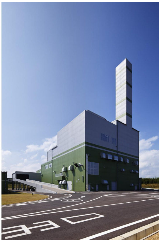
環境エネルギーセンター
