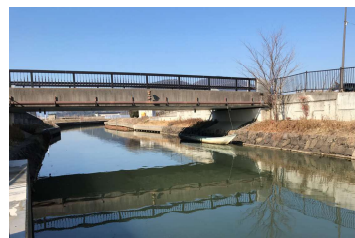
撮影：八幡川(南津田新川橋)
