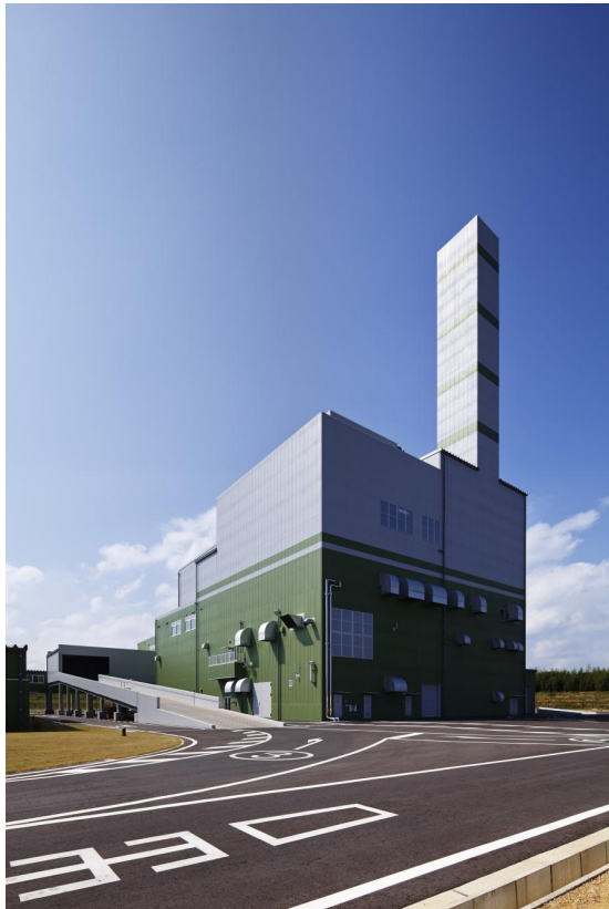
環境エネルギーセンター
