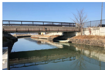
撮影：八幡川(南津田新川橋)
