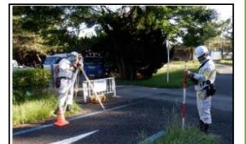
現地測量の例
