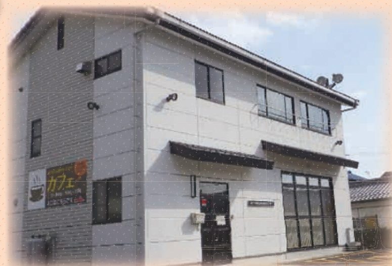
別館(カフェ) 玄関全景
