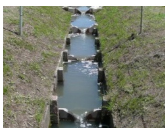
①水路魚道の設置（堰上式）
