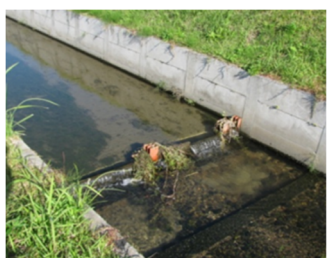
④堰板設置による水深確保
