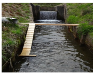
⑤水路からの脱出施設の設置
