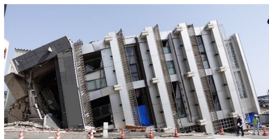
図1-2 能登半島地震での建物の倒壊状況
