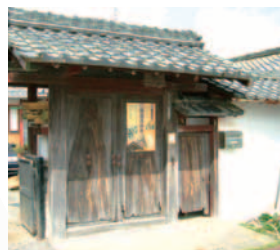
屋根門を残した主屋の改築(中村町)
