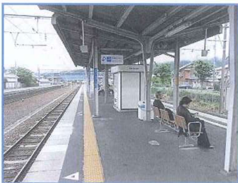
視覚障害者誘導用ブロック、ベンチ
