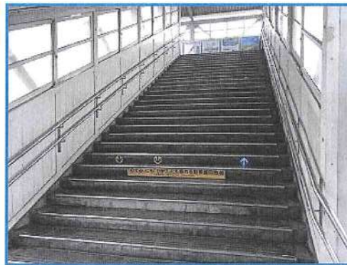
階段(2段手すりが設置されている)
