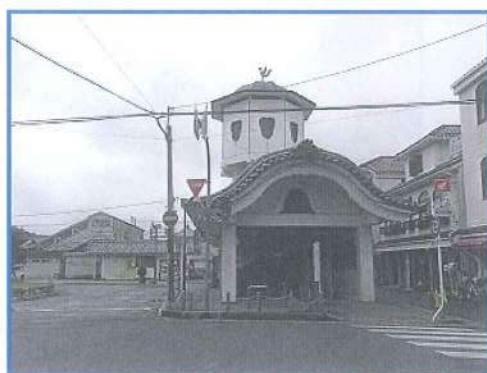
北側出入口部
