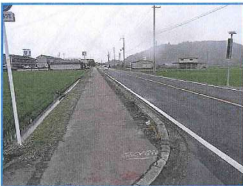
片側にセミフラット構造の歩道が設置されている
