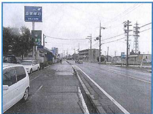
片側にセミフラット構造の歩道が設置されている
