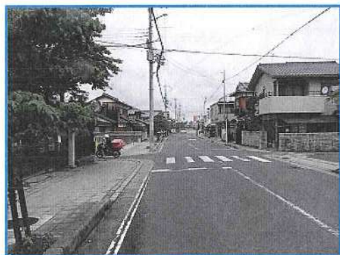
両側にセミフラット構造の歩道が設置されている
