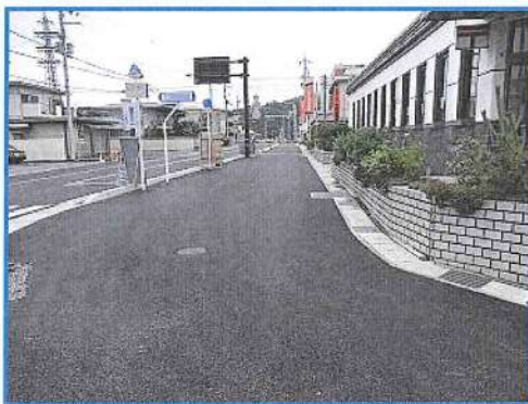
両側にセミフラット構造の歩道が設置されている
