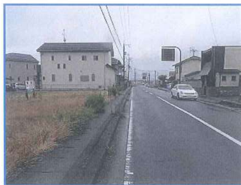
片側は水路ふたかけ歩道、片側はセミフラット構造の歩道となっている
