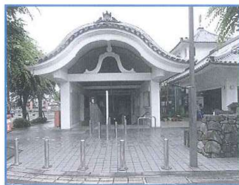
南側出入口部
