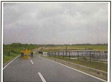
⑧建設中の(仮称)野洲養護学校
