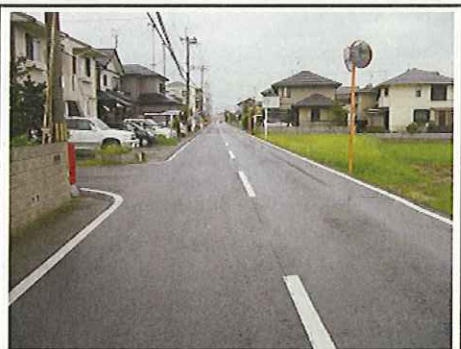
⑦篠原駅南西側（近江八幡守山線）
