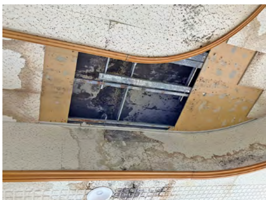
【老蘇小学校の天井】
