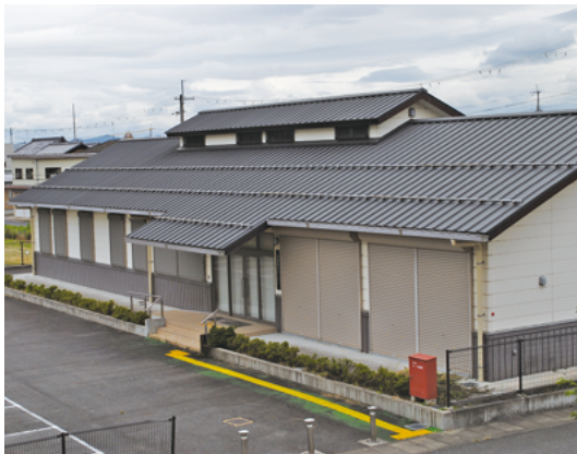
【北里防災センター】
