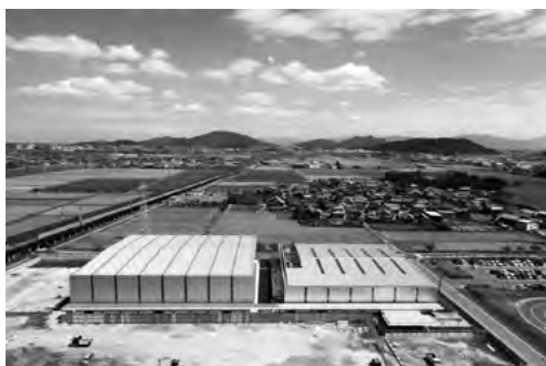
【第2期工事が完了した健康ふれあい公園】
