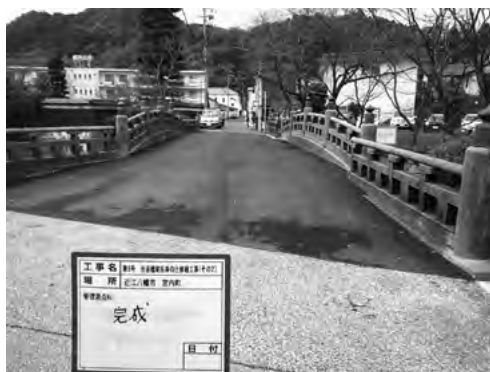
【長寿命化修繕工事をした明治橋】
