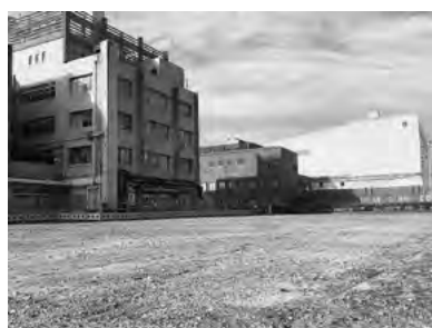
【原状復旧後の状況（市庁舎裏側）】
