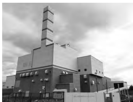
【環境エネルギーセンター】
