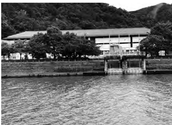
【びわこ揚水受水口】
