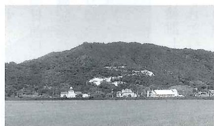
【織山防災道路工事】
