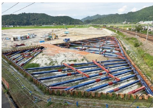
【工事中の調整池】
