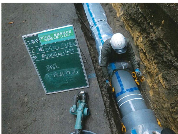
写真 5.2.2 長福寺送水管布設替え工事
