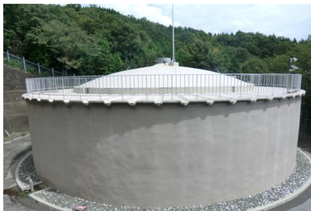
写真 2.6.11 上出配水池全景
