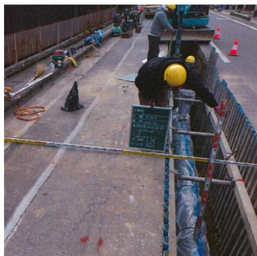
写真 5.2.3 円山路線3重要管路更新工事
