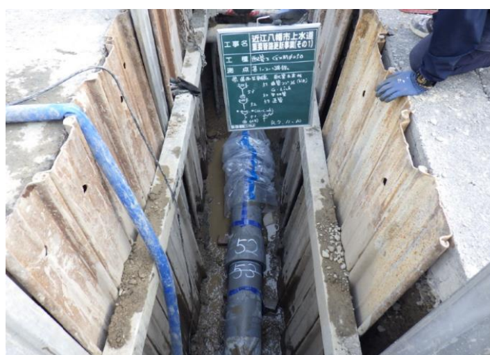
写真 3.2.1 配水管の布設状況 (配水管布設工事 GX 形 φ250mm)
