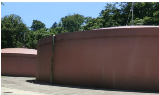
写真 2.6.9 長福寺配水池
