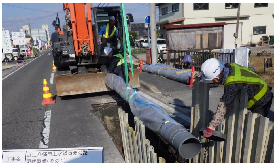
写真 5.2.1 安土重要管路更新事業
