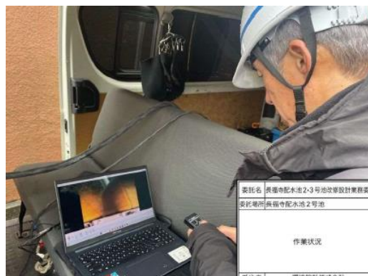
写真 5.3.2 ロボットによる清掃作業の様子
