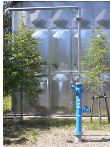
写真 2. 6. 8 牧応急給水栓
