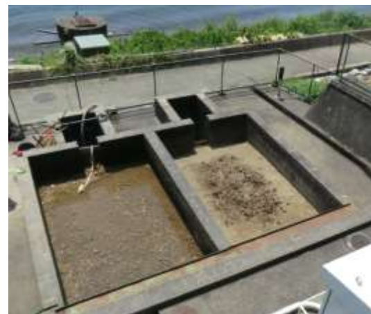
写真 2. 5. 31 汚泥天日乾燥池
