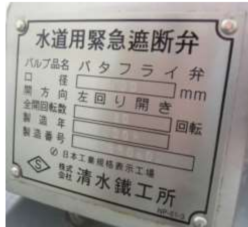
写真 2.5.39 緊急遮断弁名盤
