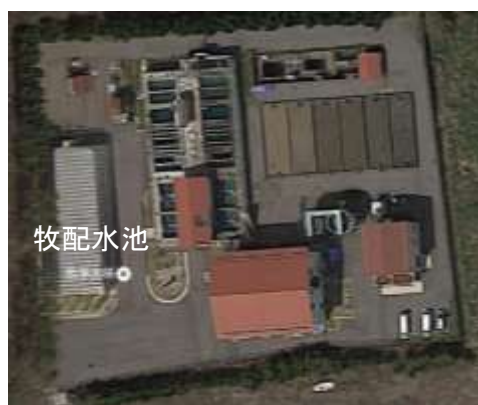
写真 2.5.32 牧配水池位置
