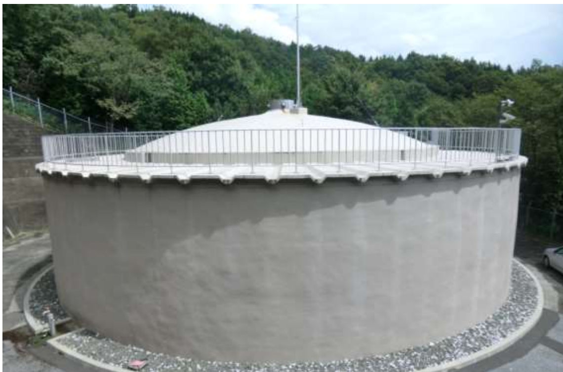
写真 2. 5. 43 上出配水池全景
