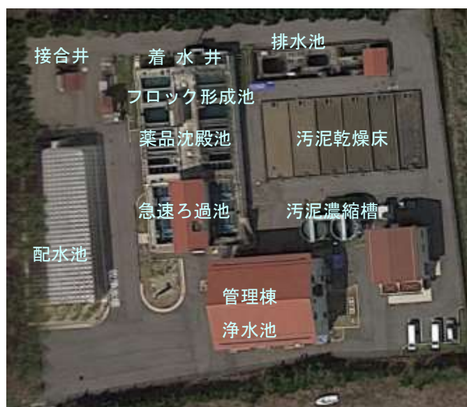
写真 2.5.3 牧浄水場施設位置図（航空写真）
