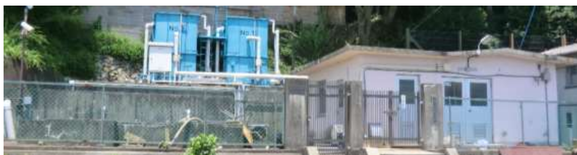
写真 2.5.21 沖島浄水場全景
