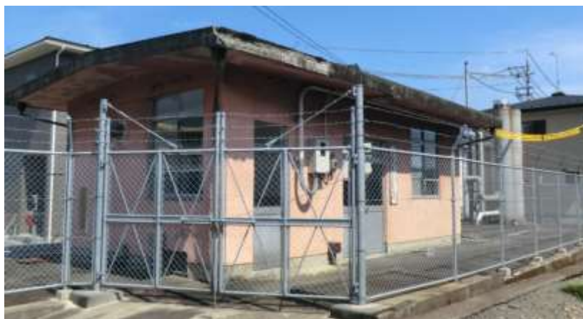
南部水源地 全景
