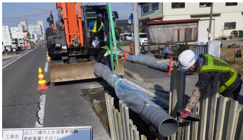
※管路耐震化工事の様子 安土重要管路更新事業
