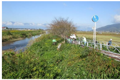
↑法面はかなり深い茂み(作業前)
