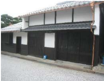
永原町中で修理した主屋
