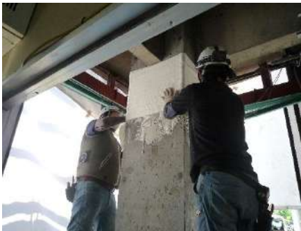
耐震補強工事中
