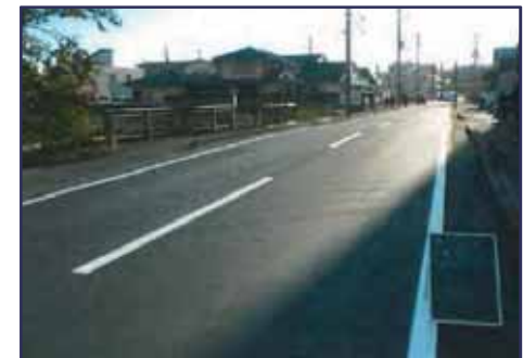
過年度の施工完了写真(金剛寺鷹飼2号線)
