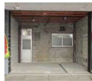
南口トイレ 新設場所
