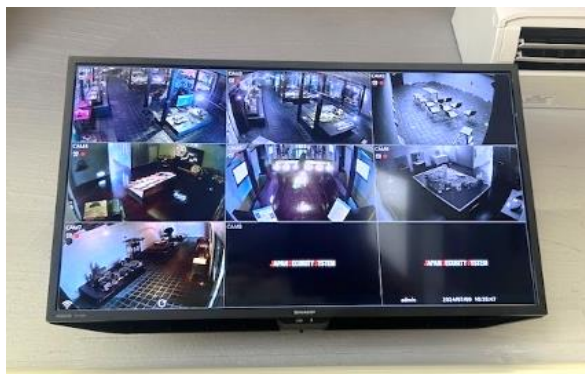
台風被害による施設修繕、防犯カメラ取替工事後の様子
