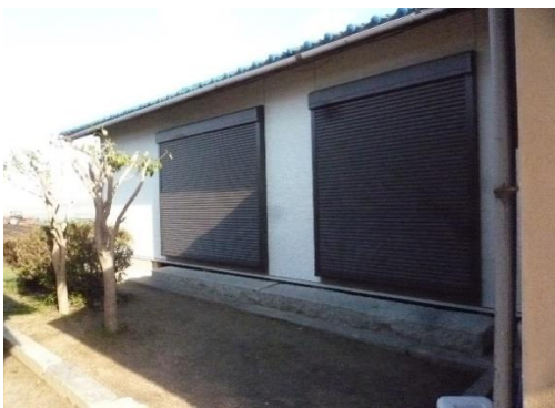
赤尾町自治会(雨戸の改修)
