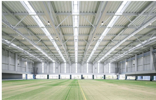
竹町都市公園（屋根付き多目的広場）
