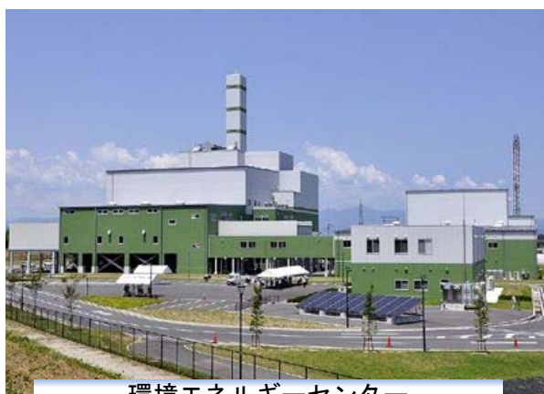
環境エネルギーセンター
