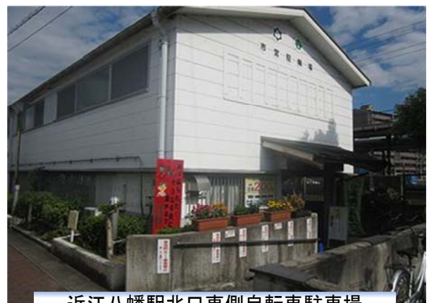
近江八幡駅北口東側自転車駐車場
