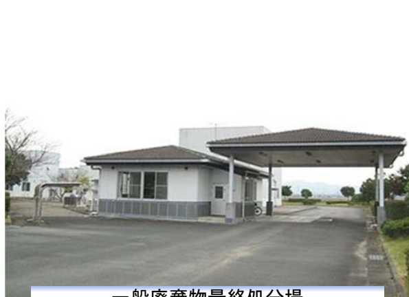
一般廃棄物最終処分場
