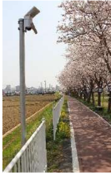
防犯灯新規設置
