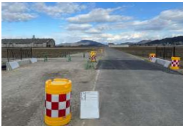
【アクセス道路（横断水路部施工）】
