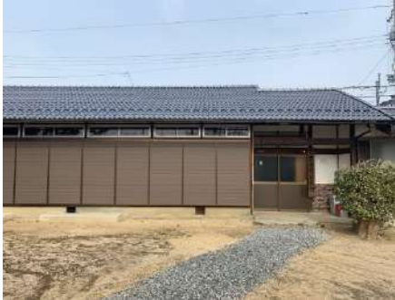
古川町自治会 大規模改修
