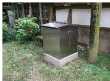
「長命寺」本堂他放水銃BOX修理
