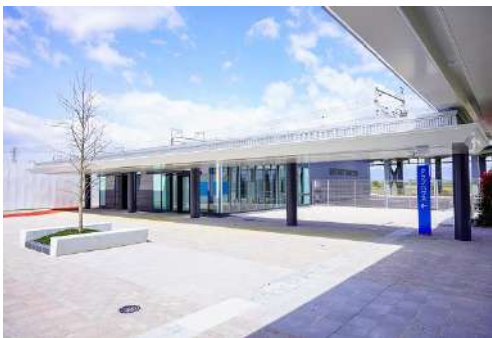
【クラブハウスの外観】
