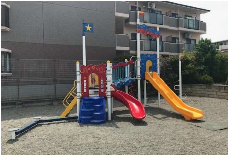
【駅南第2児童公園遊具修繕工事 完成】
