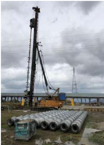
【屋根付き多目的広場整備工事 杭工事の状況】
