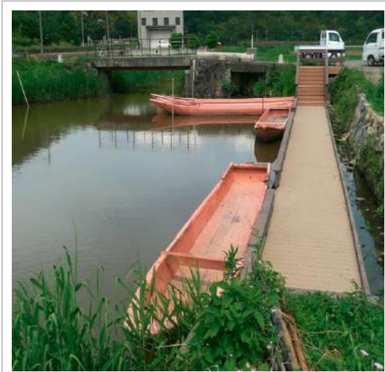
外堀工区親水デッキ整備
