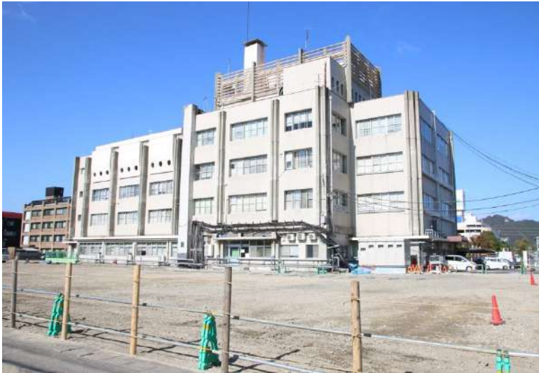
安全対策工事
