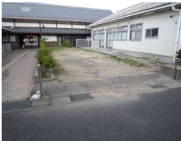
＜八幡コミュニティセンター倉庫改修＞
