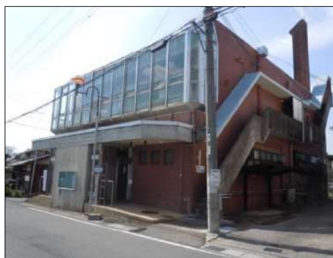
解体工事着手前の状況
