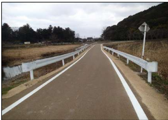
安土川工区（自然色舗装）
