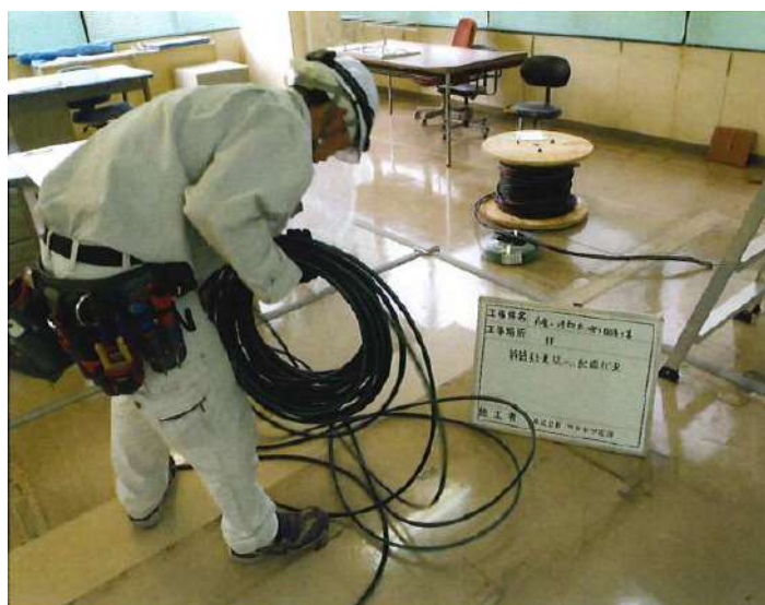
安土町総合支所の改修工事
