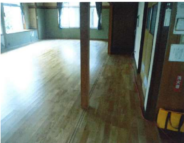
廊下と広間の段差解消(フローリング化)
