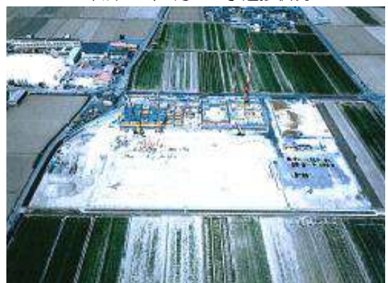
＜平成30年3月の工事進捗状況＞
