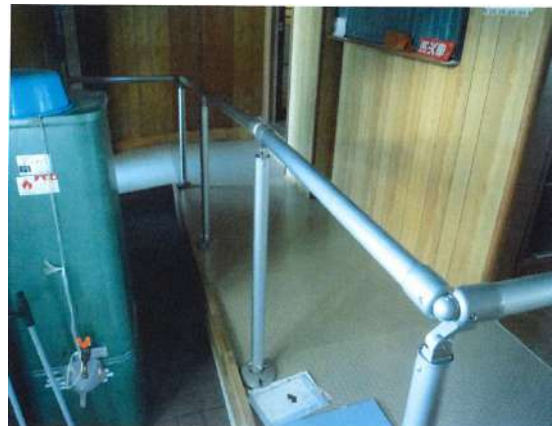
スロープ新設
