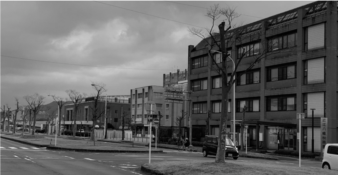
視点 C 既存庁舎
