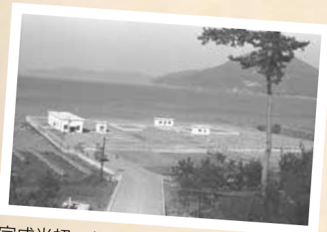
完成当初の牧浄水場 (昭和 40 年)
