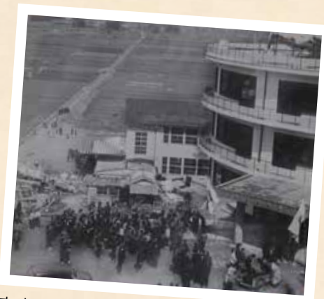
安土中学校の円筒校舎 (昭和 33 年)
