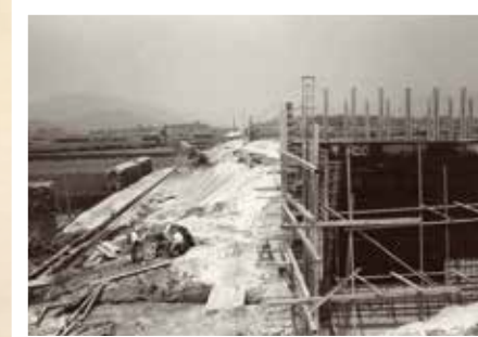
上田町の新幹線工事現場 (昭和 37 年)
