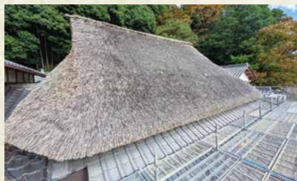
修理中の清見寺のヨシ葺き屋根
