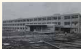
昭和 54 年に完成した校舎
