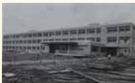
昭和 54 年に完成した校舎
