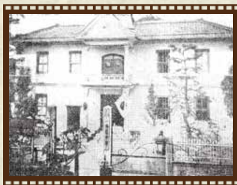
1. 旧八幡警察署庁舎
