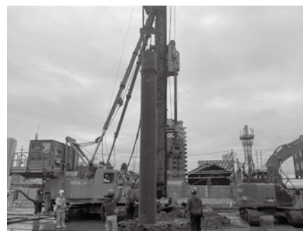
地盤にくいを打ち込む工事
