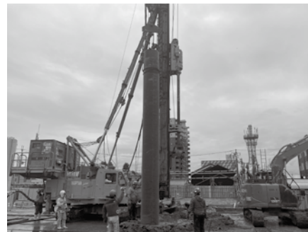
地盤にくいを打ち込む工事
