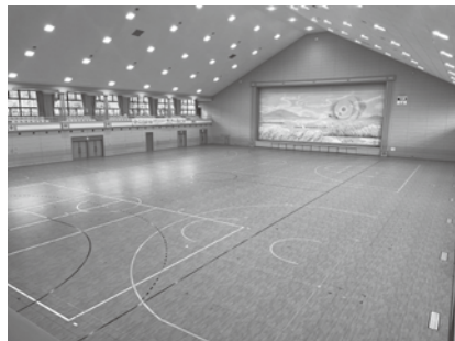
床に塩ビ素材スポーツシートを敷設
