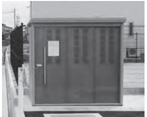
新しく設置されたごみステーション
