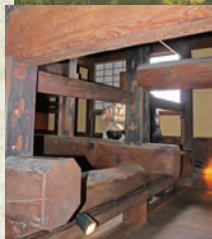
◀ 3階の「地震の間」
