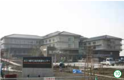
完成間近の総合医療センター
