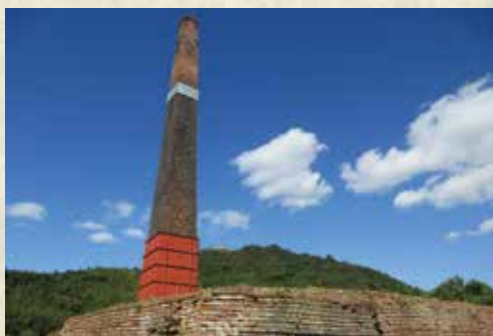
旧中川煉瓦製造所ホフマン窯
