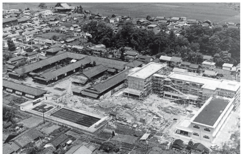
新校舎建築中の安土小学校（昭和 44 年）
