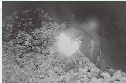
ゴミピット内火災発生時の状況
